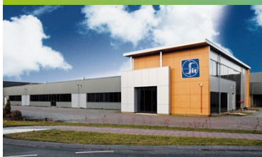
Hoogeveen (Olanda) Controlli elettronici
