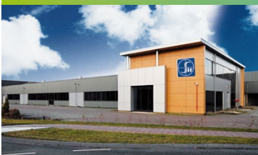
Hoogeveen (Olanda) Controlli elettronici
