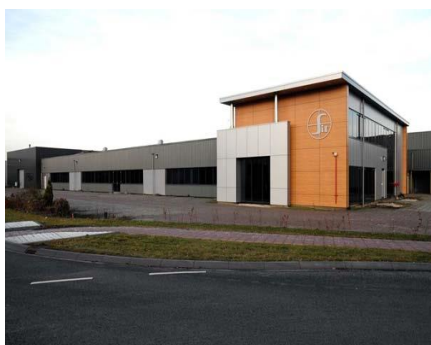
SIT SPA – Hoogeveen plant
